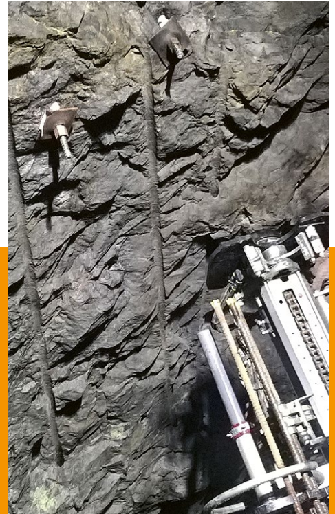
Selbstbohrender Anker mit MasterRoc RBA 380
